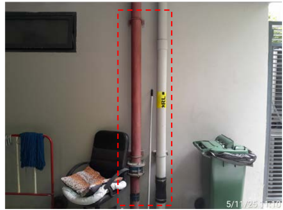
รูปที่ 2-33 ท่อส่งน้ำดับเพลิง
